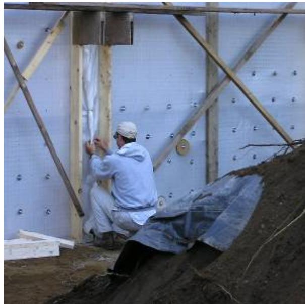
Fig. 7. Wall Form Placement
