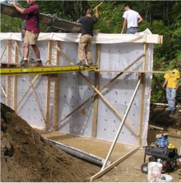
Fig. 10. Concrete Pour
