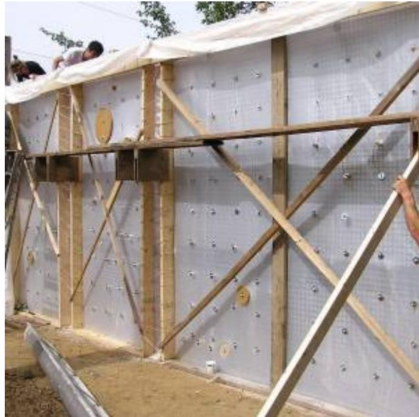
Fig. 8. Wall Form Placement
