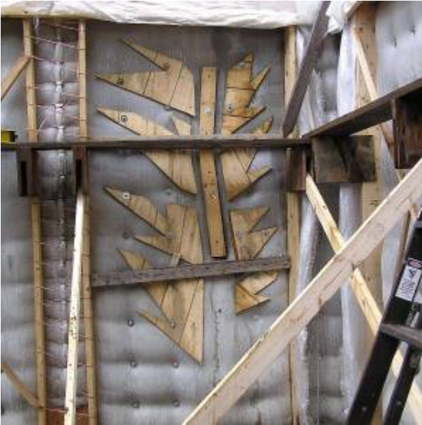
Fig. 18. Completed Concrete Pour
