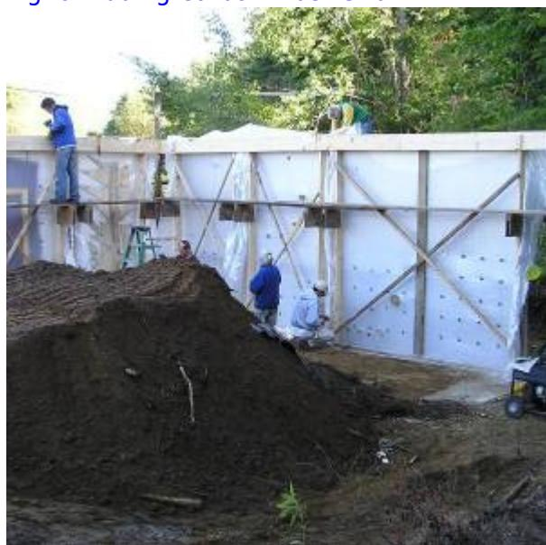
Fig. 7. Wall Form Placement
